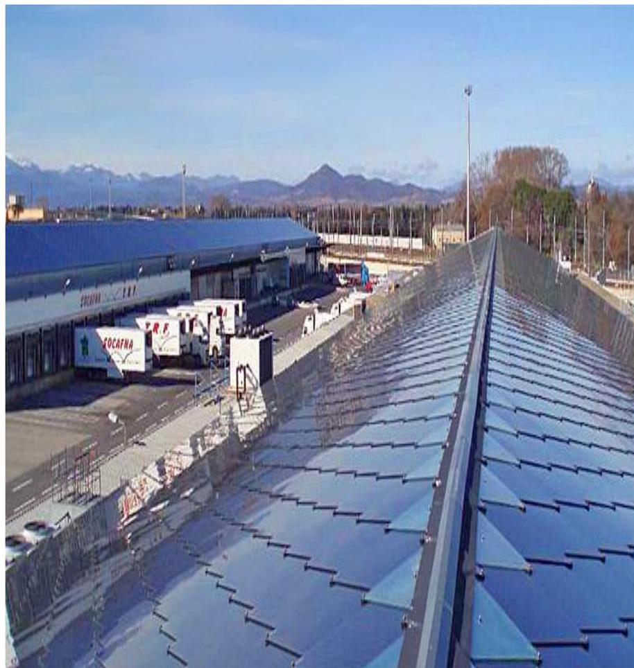
La ristrutturazione della copertura ha visto sostituire 68 mila metri quadrati di superficie con 97 mila tegole fotovoltaiche, per una produzione complessiva di 9.800 MWh che riesce a soddisfare quasi il 10% del fabbisogno energetico della cittadina di Perpignan .
